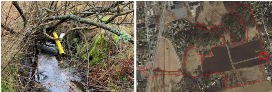
Figur 10 Dagvatten från ovanliggande fastigheter leds till bäcken via det norra diket.
