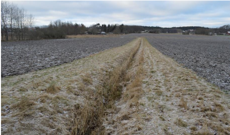
Figur 9 Det norra diket är ca 0,6 meter djupt.
