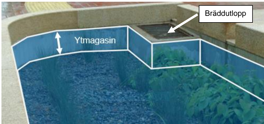
Figur 47 Illustration av ytmagasinet ovanpå filterbädden i ett biofilter. Källa: Sweco.
